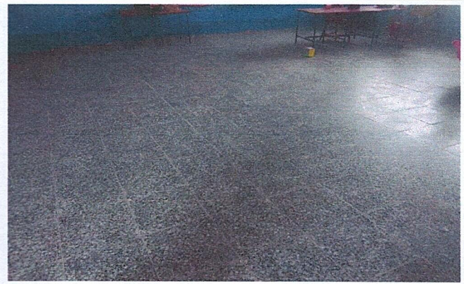
Foto 2: Pisos instalados Aula 3
