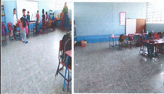
Foto 1: Piso cerámico mejorado e instalado. Aula 1 y 2.
